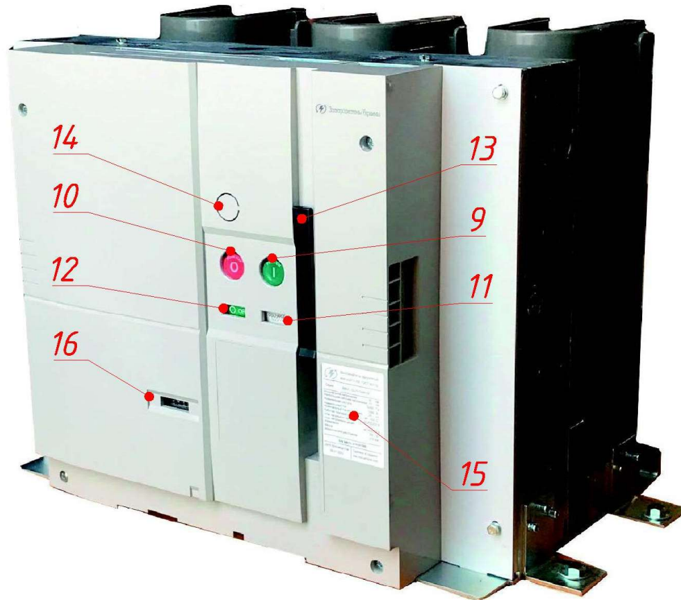
Рисунок 4.2 — Передній вид вимикача типу BB-VL
